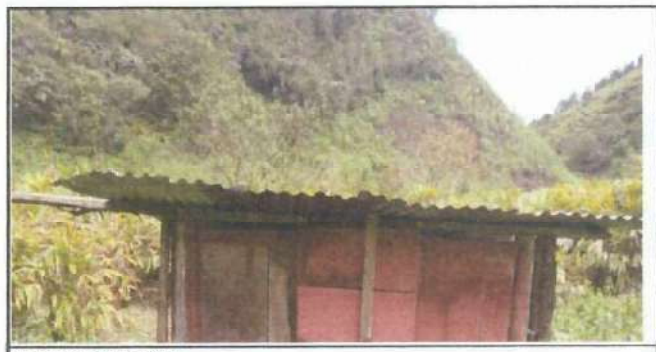
Techo de los baños,.
