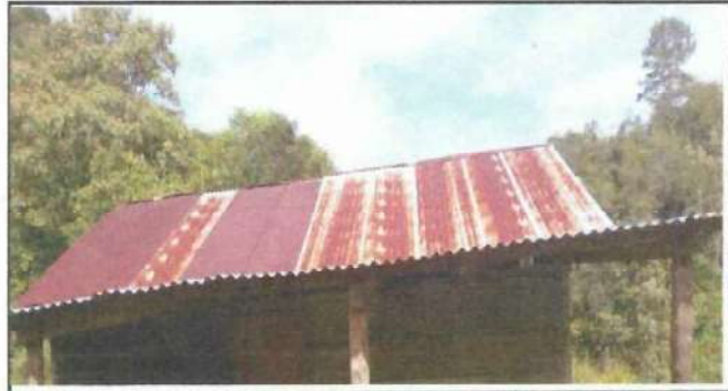
Techo de la cocina
