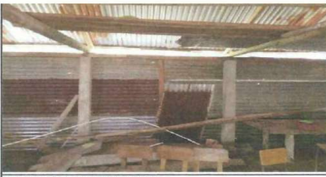
Paredes actuales del modulo cocina
