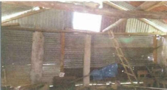
Paredes del lado dentro de la cocina
